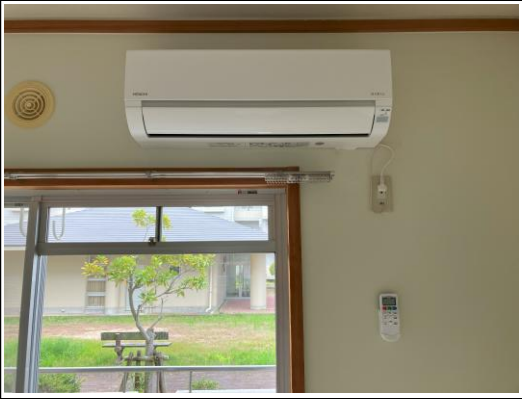
エアコン2台設置
