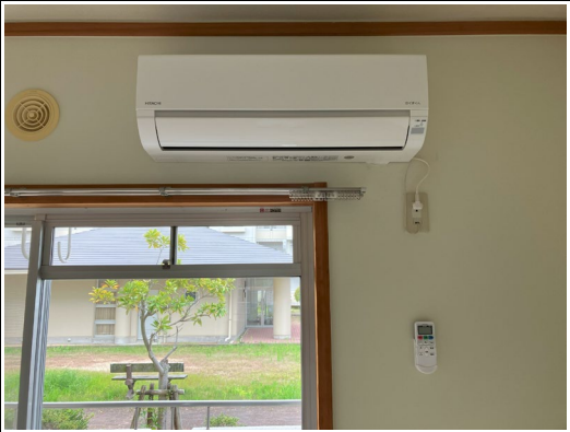
エアコン2台設置
