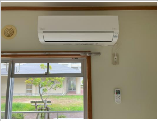
エアコン2台設置
