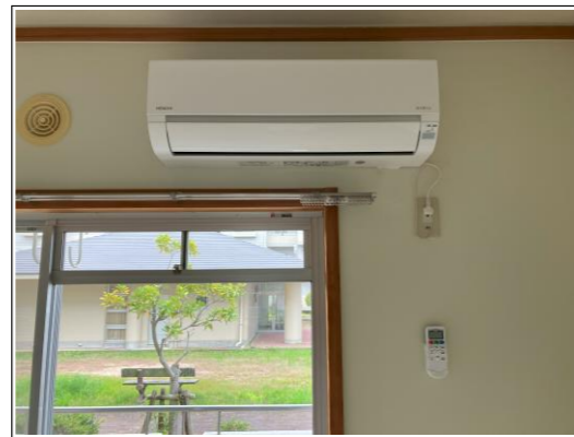
エアコン2台設置
